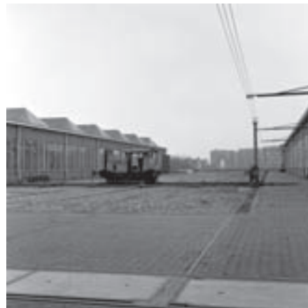
De traverse tussen de hallen
