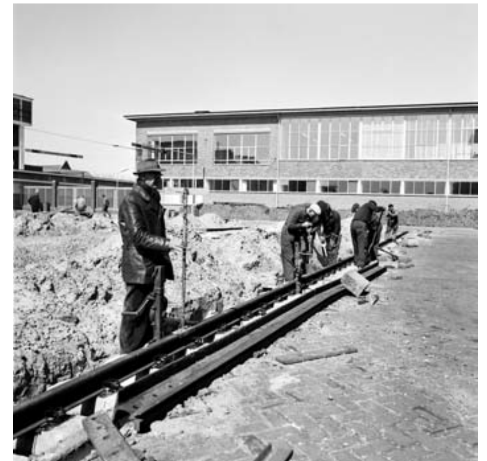
De bouw van de traverse
