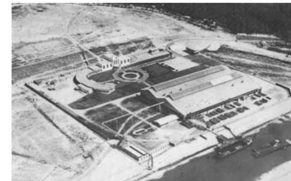
Een naoorlogse luchtfoto van het bedrijf dat toen Walserij Oost heette; achter het gazon zien we het tentoonstellingsgebouw annex restaurant
