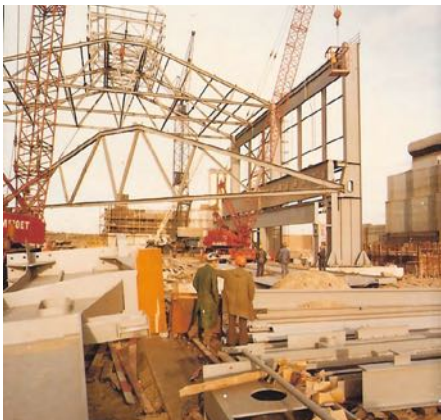
Bouw cointinugietmachine in OSF-2, 25 november 1978
