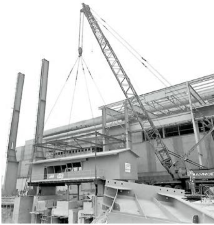
Plaatsing bedieningscabine cointinugietmachine in OSF-2, 3 augustus 1978
