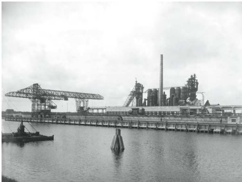
Bouw van de buitenhaven (1923)
