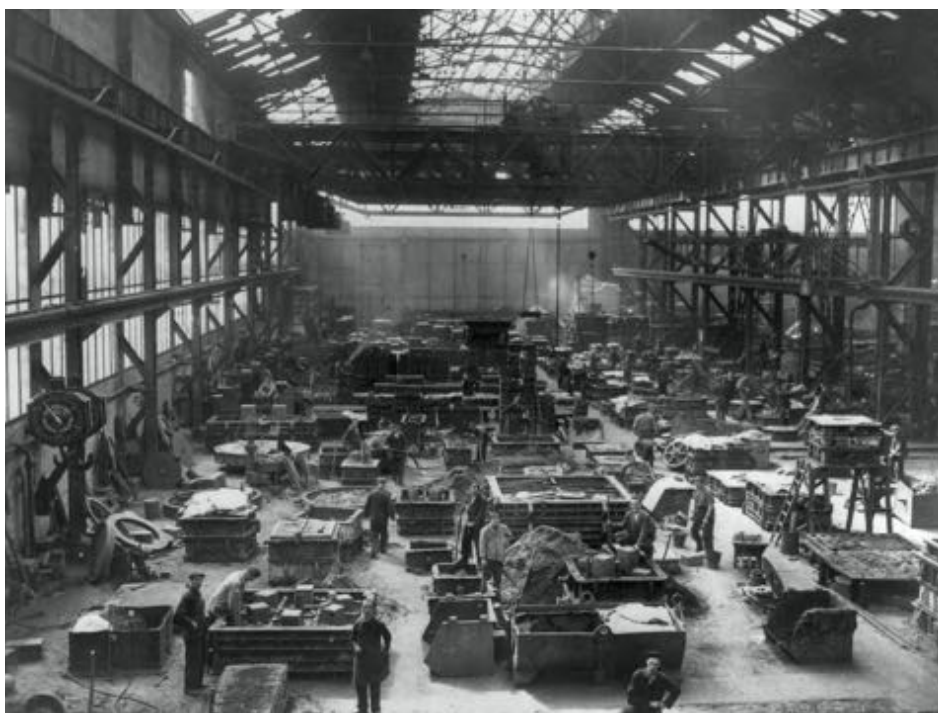
Interieur van de voormalige van de DEMKA fabriek, ca. 1955
