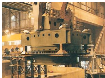
Plaatsen draaitoren cointinugietmachine in OSF-2, 6 november 1979
