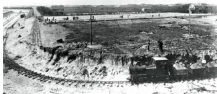
Grondwerkzaamheden buitenhaven met rechtsboven het huis van Marinus, augustus 1921
