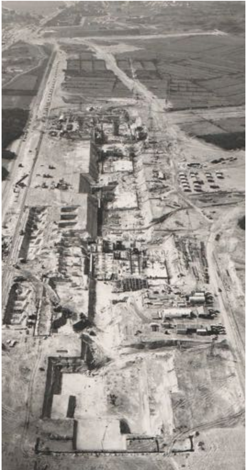
Warmbandwalserij 2 in aanbouw, luchtfoto van het gebied ten noorden van de Zeestraat (1967)
