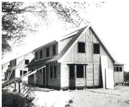
Oostenrijkse woningen aan de Tuinderslaan, 1921
