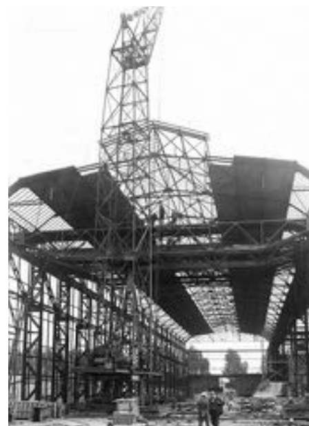
Een van de hallen in aanbouw in Zuilen
