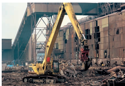
Het slopen in volle gang
